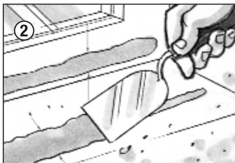
Mit einer Spachtel die Klebstoffraupe am Bauwerk auf ca. 4–5 cm Breite und 1 mm Dicke (je nach Untergrund) verziehen, am Fensterelement genügt eine Breite von 2–3 cm und eine Dicke von 1 mm.
