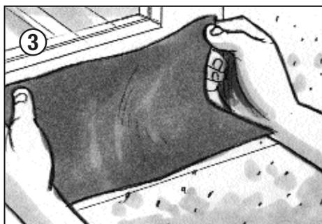
**SikaMembran®-Folie** schleifenförmig und spannungsfrei ankleben. Folie in den Klebstoff eindrücken. Bei Folienüberlappungen mindestens 5 cm Überlappungslänge einhalten.
