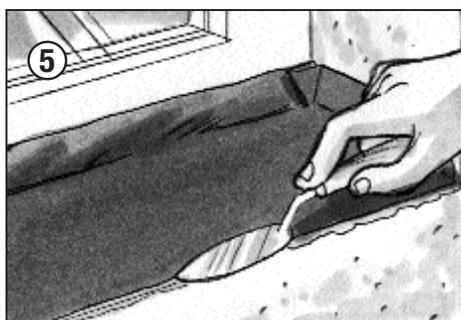
Anschliessend die Folienkante mit einer Spachtel in den überschüssigen Klebstoff einbetten.
