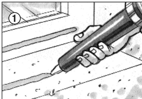
Klebstoff **SikaBond®-TF plus N** mittels Schlauchbeutelpistole und Düse auftragen. (Düsendurchmesser ca. 8 mm)
